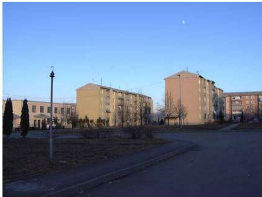
Микрорайон Хольцман, г. Владикавказ Разжижение грунтов возможно при 8 балльном землетрясении M_{max}=7.1
