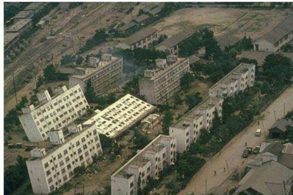
Разжижение грунтов 16 июня, 1964, Ниигата, Япония, M_{max}=7.5
