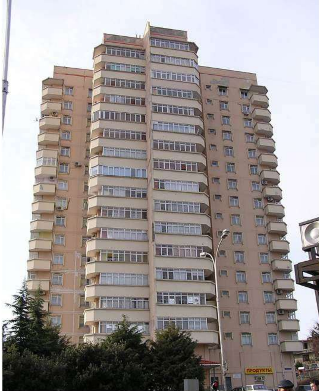
16-ти этажный 120 квартирный жилой дом из сборных керамзитобетонных панелей в пос. Лазаревский г. Сочи. Сейсмоизоляция выполнена после монтажа всего каркаса здания.
